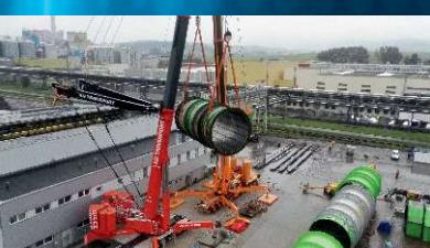
Predmontáž, demontáž a montáž odkŕňovacieho
