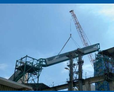
Predmontáž a montáž dopravníkových mostov pre
