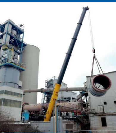
Výmena výstupu rotačnej pece s podporákom –
